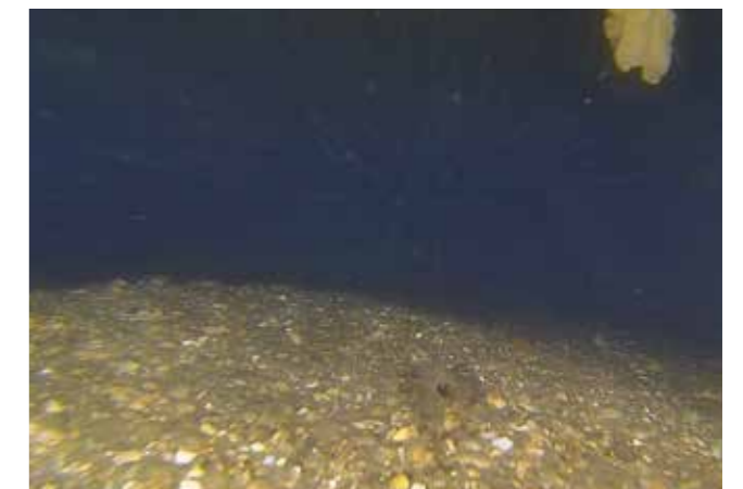
中に入ってみると下部には砂が堆積しています。
