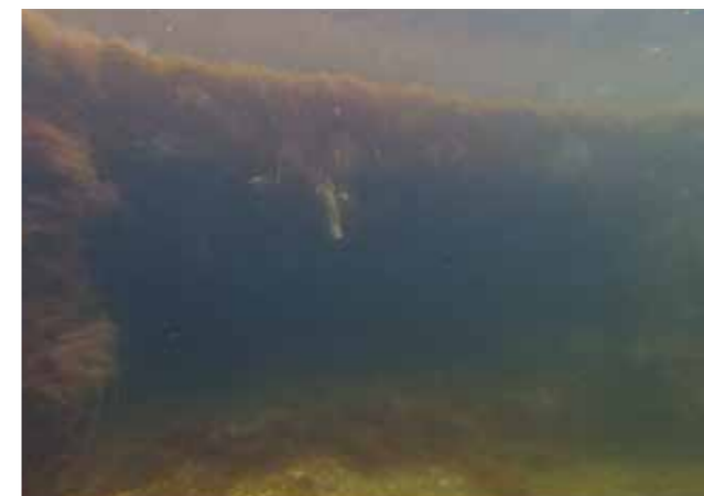
お堀の参道の下にある海水の通り道。50cm×150cmのものが3つあります。
